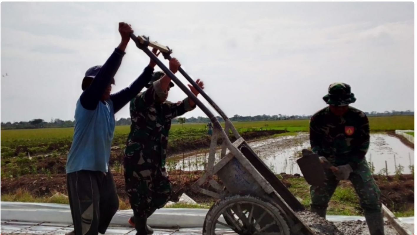
Giat Anggota Satgas TMMD dan Masyarakat Kebut Pengecoran Jalan Pertanian Desa Rejosari Kecamatan Mijen
